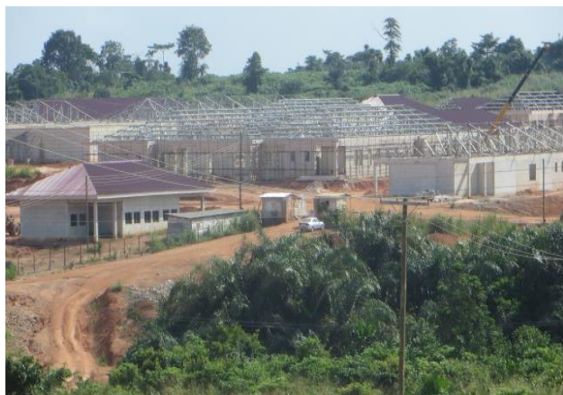
クマシ州病院建設現場
