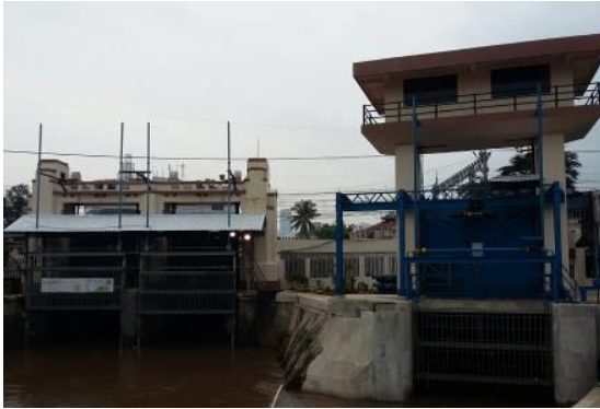
マンガライにあるゲートにより流量能力は 330m 3 /秒から 570 m 3 /秒へ向上
