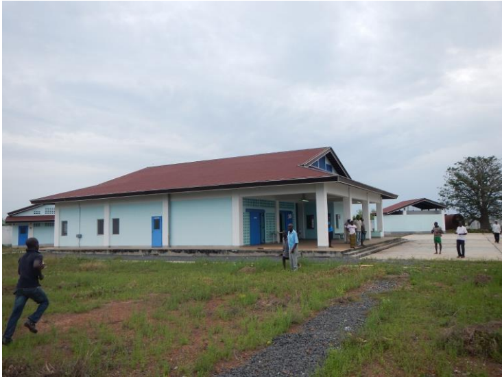
カシーン管理棟
