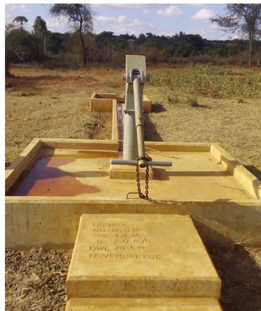
写真2 キクルミ村の給水施設
