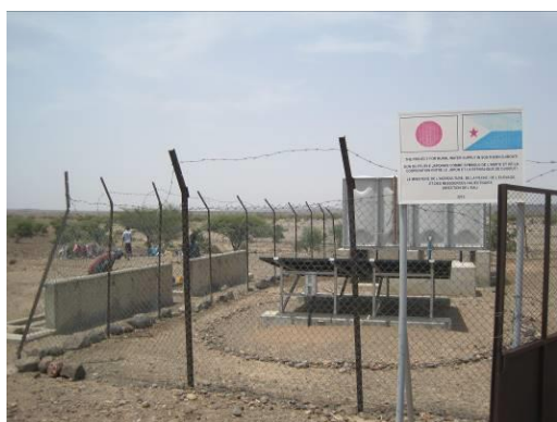
フカアラバ給水施設
