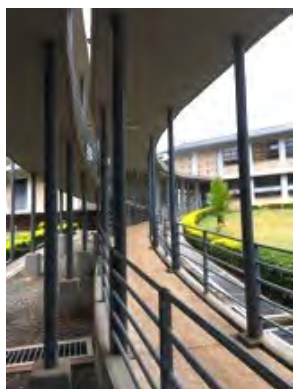
施設内のスロープ 講義棟と実験棟の間や各階への 移動が車椅子で可能。
