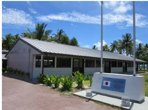
本事業で建設した一般教室棟
