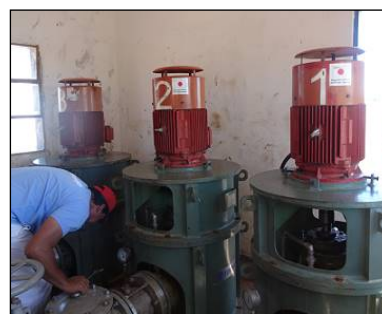
ピラール浄水場： 取水ポンプの点検の様子
