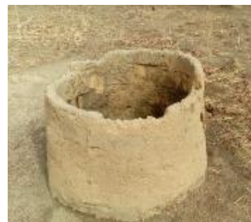
サバネス州トン県で以前利用されていた伝統的手掘り井戸
