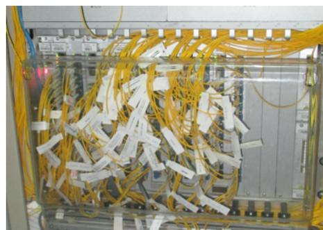
事後評価時：ラベルが付されており、必要に応じて束ねられているため、ケーブルの行き先が一目でわかる。
