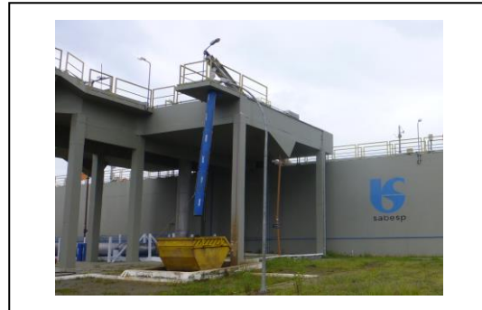
イタニャエン市に新設した下水処理場
