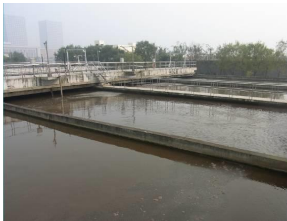
西南郊地区下水処理場の生物反応池
