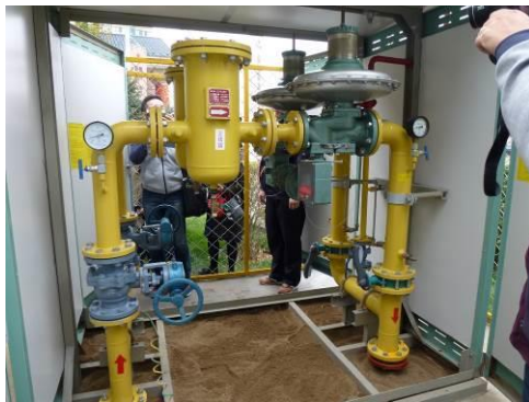
住宅団地に設置の レギュレーターキャビネット
