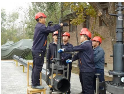
研修所でのガス管交換工事实演
