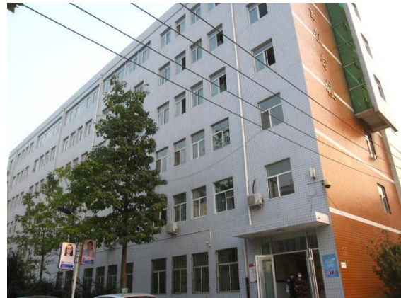
本事業で建設された教学棟（河北女子職業技術学院）
