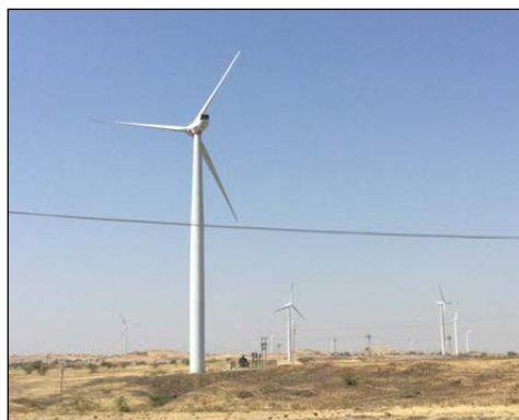
本事業融資対象の風力発電所
