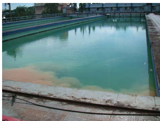
浄水場沈砂池：手前が原水
