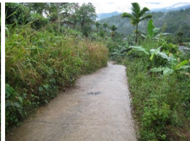
サバラガムワ州ラトナプラ県の州道 Mahalahena Silidunkanda Hettikanda Road
