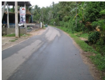
中部州マータレー県の州道 Kaduwela Wehigala Leliambe Road
