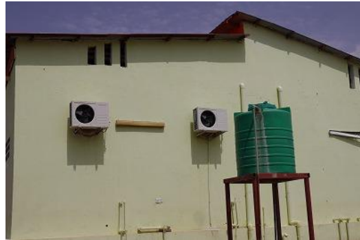
事後評価時に改修されたスキ・ローカリティ 病院産科棟
