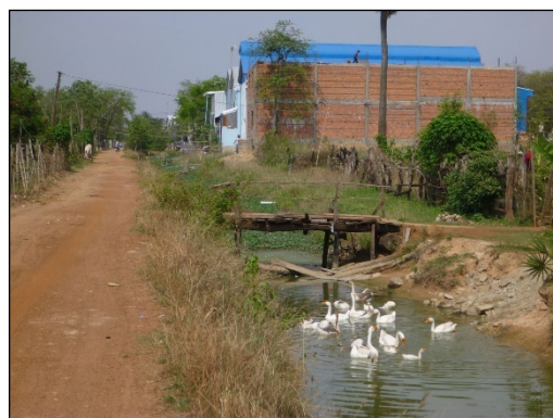
本事業で改修を行った灌漑水路
