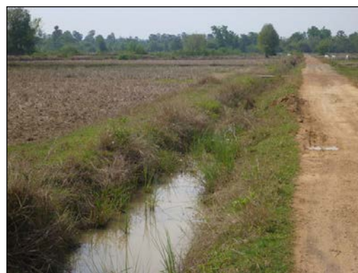
本事業で改修を行った末端水路
