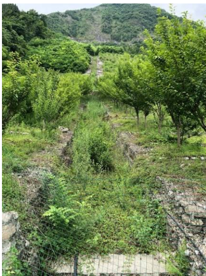
北川県の本事業試験施工地
