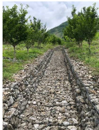
本事業の技術を使用した北川県の独自施工地
