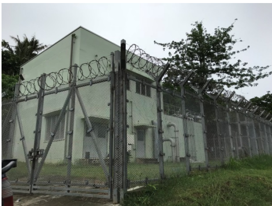
本事業で設置されたフェンス （ボーダーラインポンプ施設）
