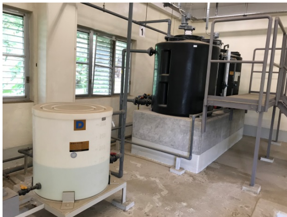
使用されていなかった塩素処理施設 (タサヘポンプ場)
