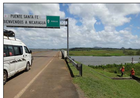
FOMAV による側溝の清掃作業
