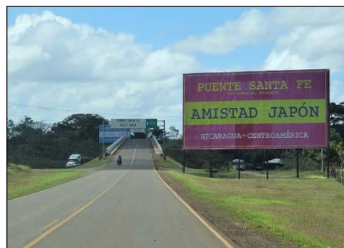
取付道路と橋梁
