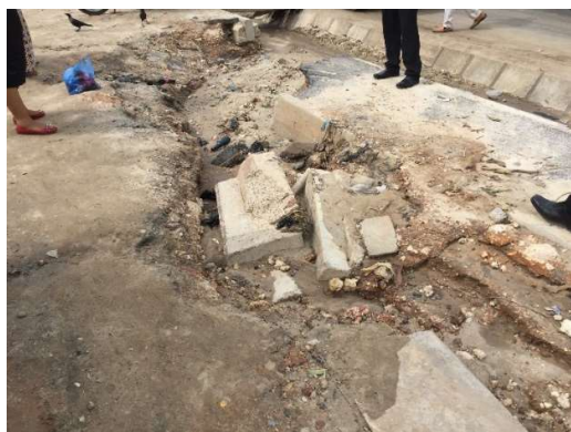
写真4 豪雨で崩壊した側溝と歩道
