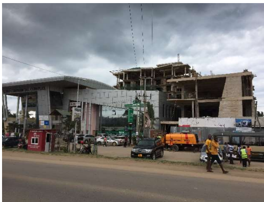
写真1 沿道に建設中の近代的なビル
