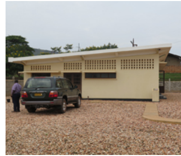
ルインクワブ変電所建屋
