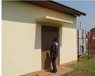
ゴマ配電ポスト (フイエ郡配電網)
