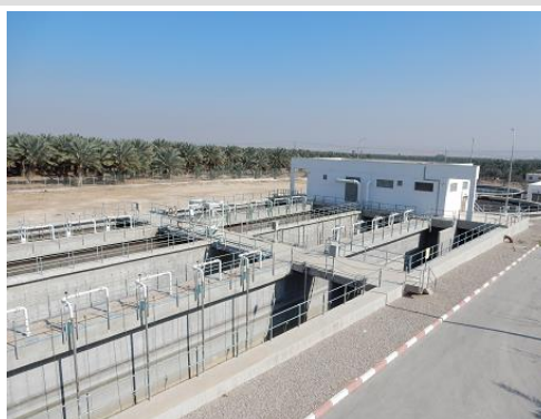
建設された下水処理施設
