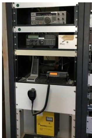
緊急災害・防災放送用連絡システム (SIBC 本局内)
