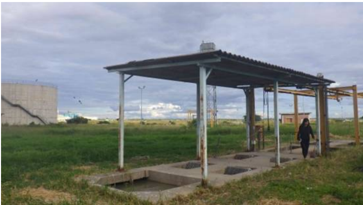
ゼンザ下水処理場の沈砂池
