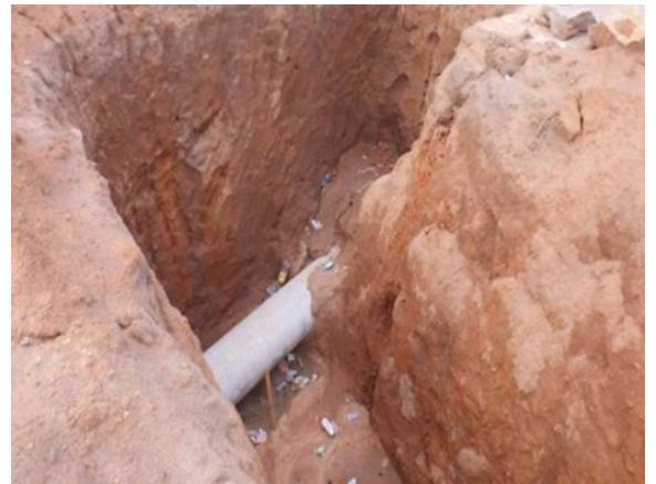
チトゥンギザで新たに敷設された水道管
