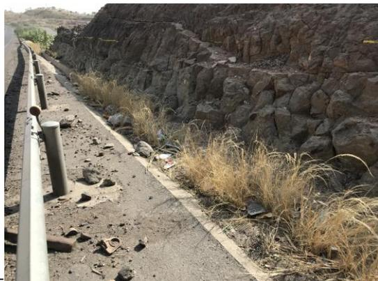
写真1 土砂とゴミに覆われた排水施設
