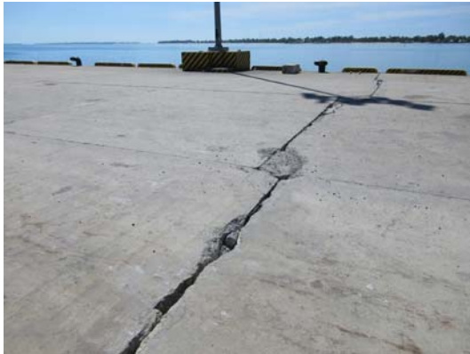
係留棧橋上面部の破損
