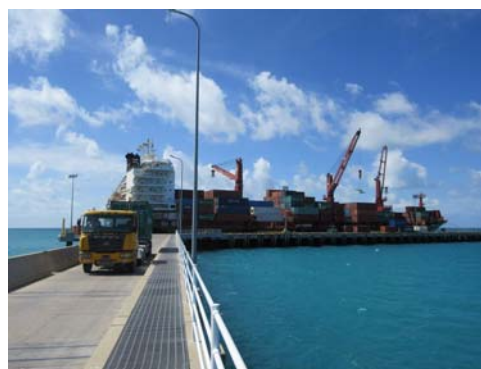
本事業で整備した栈橋・連絡橋
