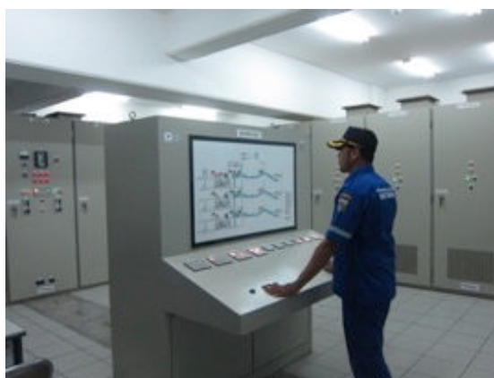
写真 5：東排水機場建屋内でポンプ操作するオペレーター
