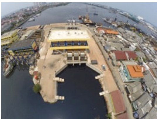
写真 1：改修後の東排水機場全景 8
