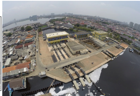
改修後のプリーツ東排水機場 2
