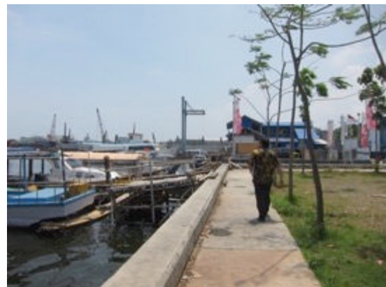
写真 2：改修後の防潮堤西側から
