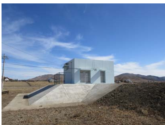
本事業で建設した井戸
