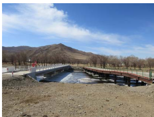
維持管理用橋梁（左側）と仮設橋
