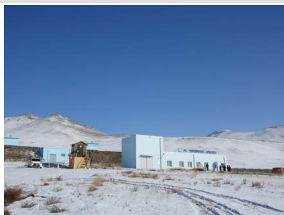
塩素消毒・操作棟及び配水池
