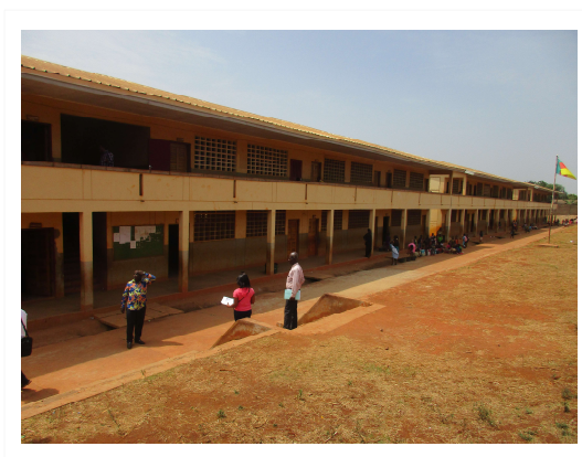
本事業で整備された2階建て教室棟
