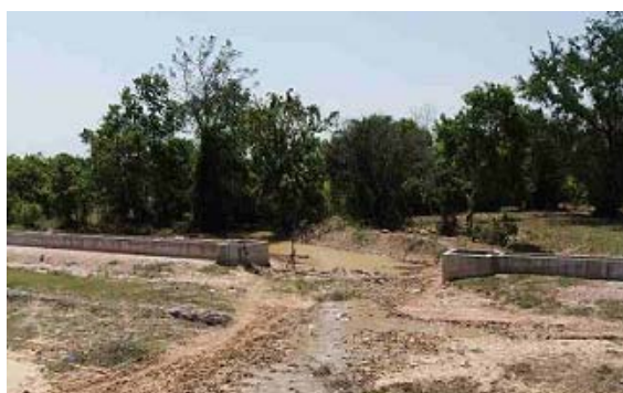
写真5 ホウアイカオ橋下流側の状況
