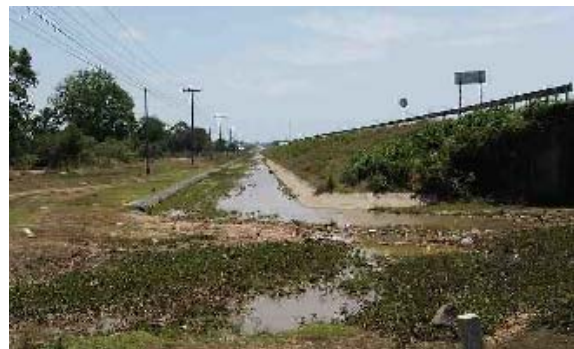
写真 4 国道九号線北側の排水路
