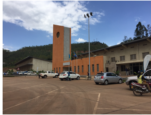
本事業により整備された OSBP 施設
