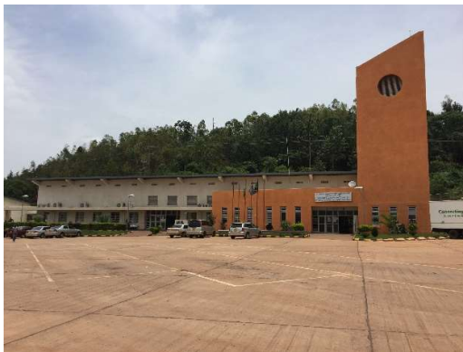
写真1 OSBP 施設 総合管理事務所
