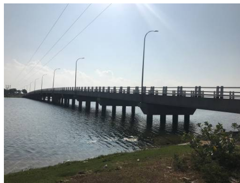
マンムナイ橋梁
