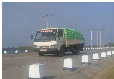
写真2 橋の開通がトラックの配送 時間とコストの短縮にも貢献
