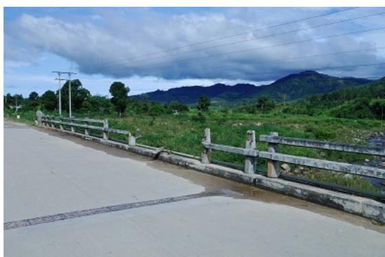
2009 年の大洪水で破損した Ngoc Tu 橋の欄干
