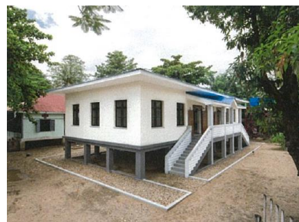
新設された RHC（高床タイプ）の外観
