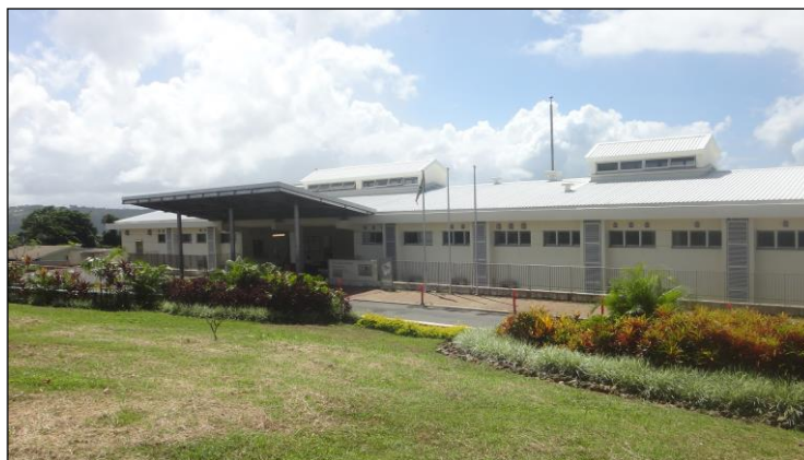
本事業で建設した新病院
