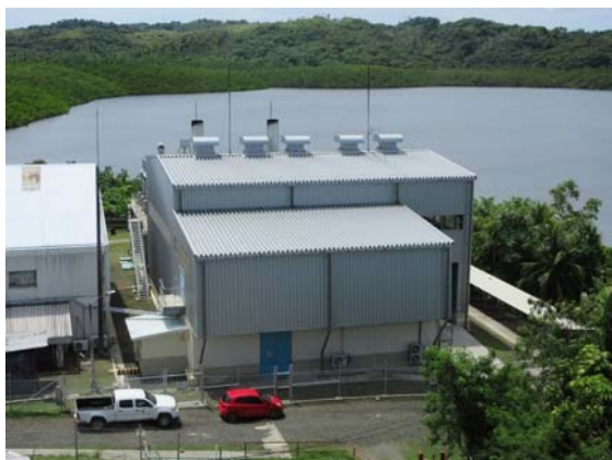
発電建屋全景
