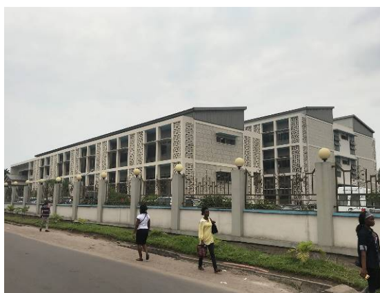
管理棟（手前）・研修棟（奥）
