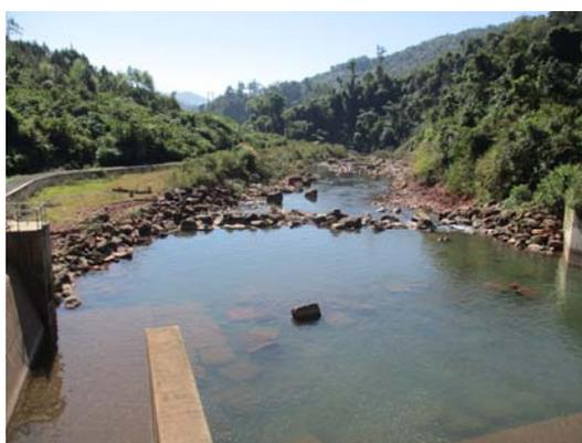
図2 流出した護床工ブロック
