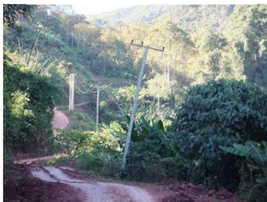
図3 傾きかけた電柱
