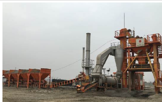
アスファルト・プラント
