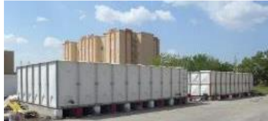
サンフィル消防署の貯水槽
