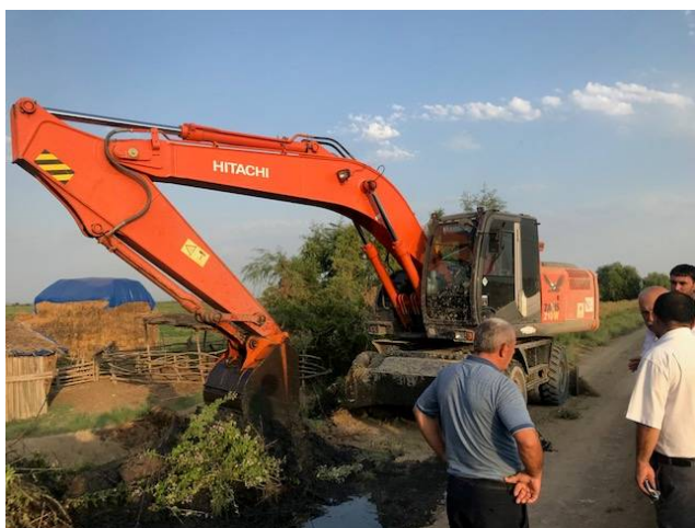
作業中のエクスカベータ、AWF 県事務所職員と農民（アグジャベディ）
