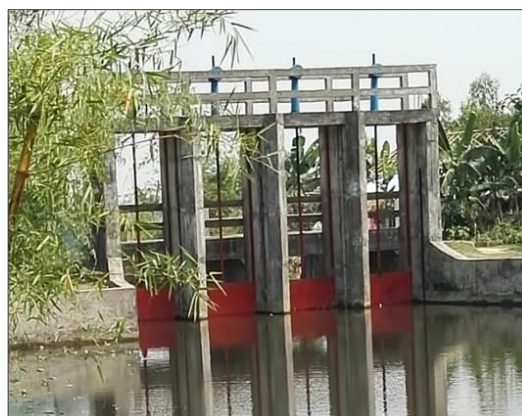
建設された調整水門 (Binna Kandi SP：シレット圏)
