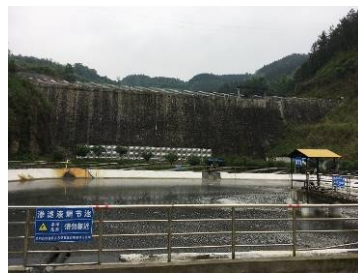
廃棄物処理場の浸出水処理施設
