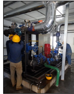
熱交換ステーションのメンテナンス (フフホト市城發投資 経営有限責任公司)
