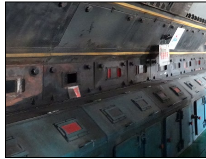
辛家営熱源 B 工場のボイラー (フフト市城發投資經營有限責任公司)
