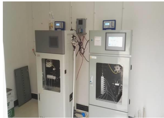
排水の水質オンライン モニタリング設備（桑植）
