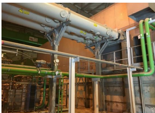
写真3：蒸気タービン室
