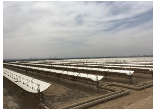
写真 2 : 太陽熱集熱器
